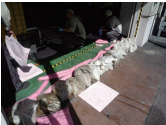
土嚢と液体吸着剤の設置(訓練)
