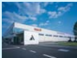
カーエアコン軸受工場
