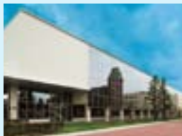
大型ロボット工場
