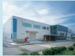
油圧バルブ工場
